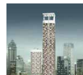
SINARMAS MSIG TOWER, JAKARTA LUAS AREA YANG DAPAT DISEWA: ±68.525 m 2 RENTAL SPACE: ±68,525 m 2
