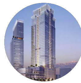
SOPO DEL TOWER Jakarta
