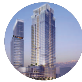
SOPO DEL TOWER Jakarta
